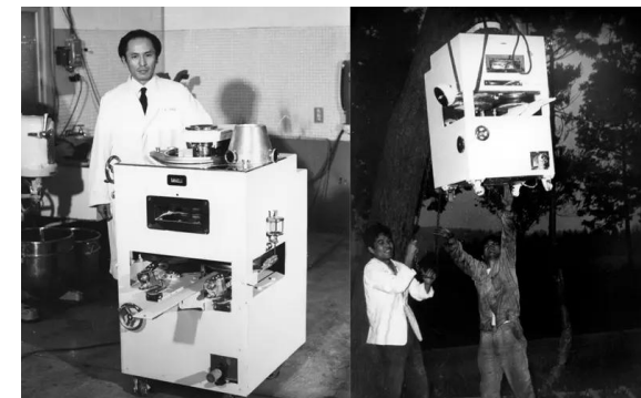
「夢の機械」とも報道された、 包あん機「N101型」初号機出荷の様子
